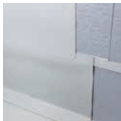
Zwischenfixierung mit Verbundblechwinkel
