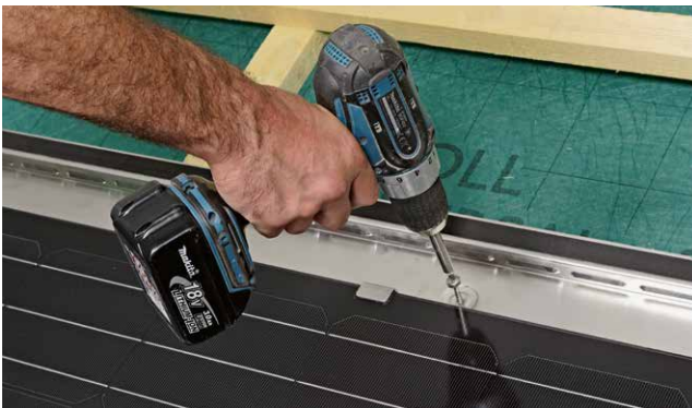
Solaranlagen fachgerecht installieren: eine Aufgabe für unsere Dachprofis.
