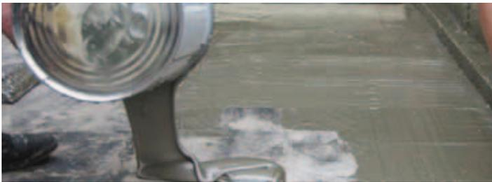
Mittels Gummischieber SOPRAVAP 3/1 gleichmäßig verteilen.
