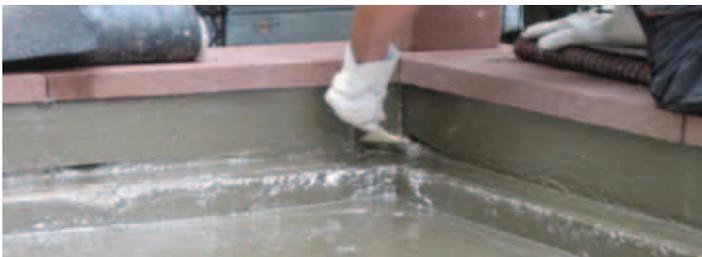
Nach Applizierung der Fläche mit SOPRAVAP 3/1 sofort die Wärmedämmung verlegen.
